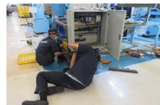
Gambar 13. Proses Instalasi Kelistrikan
