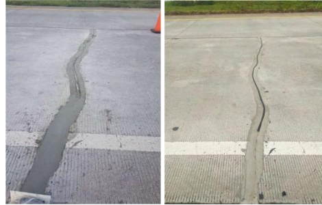
Gambar 8 Patching Cement 25 Januari dan 14 Juli 2022
