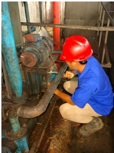
Gambar 5. Pengencangan *belting* pompa *vacuum dryer*.
