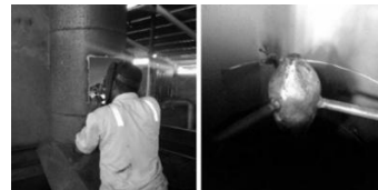
Gambar proses pemasangan payung pengarah
